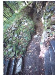
Après le passage des rénovateurs, la tranchée la plus proche du cimetière.
