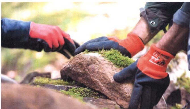
Des pierres entassées forment les parements des tranchées.
